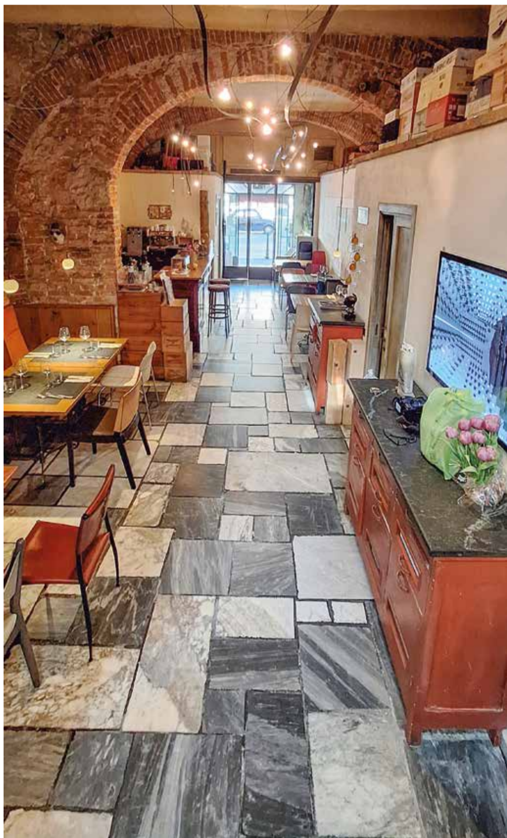
A sinistra, gli interni del ristorante Il posto che presenta una pavimentazione in marmi misti di Nuvolato di Carrara, Bianco Carrara e Calacatta Vagli. Sopra, la sede del Comune di Pietrasanta (ex ospedale Luisi) con pavimentazione in Bianco Carrara e Bardiglio Cappella.
